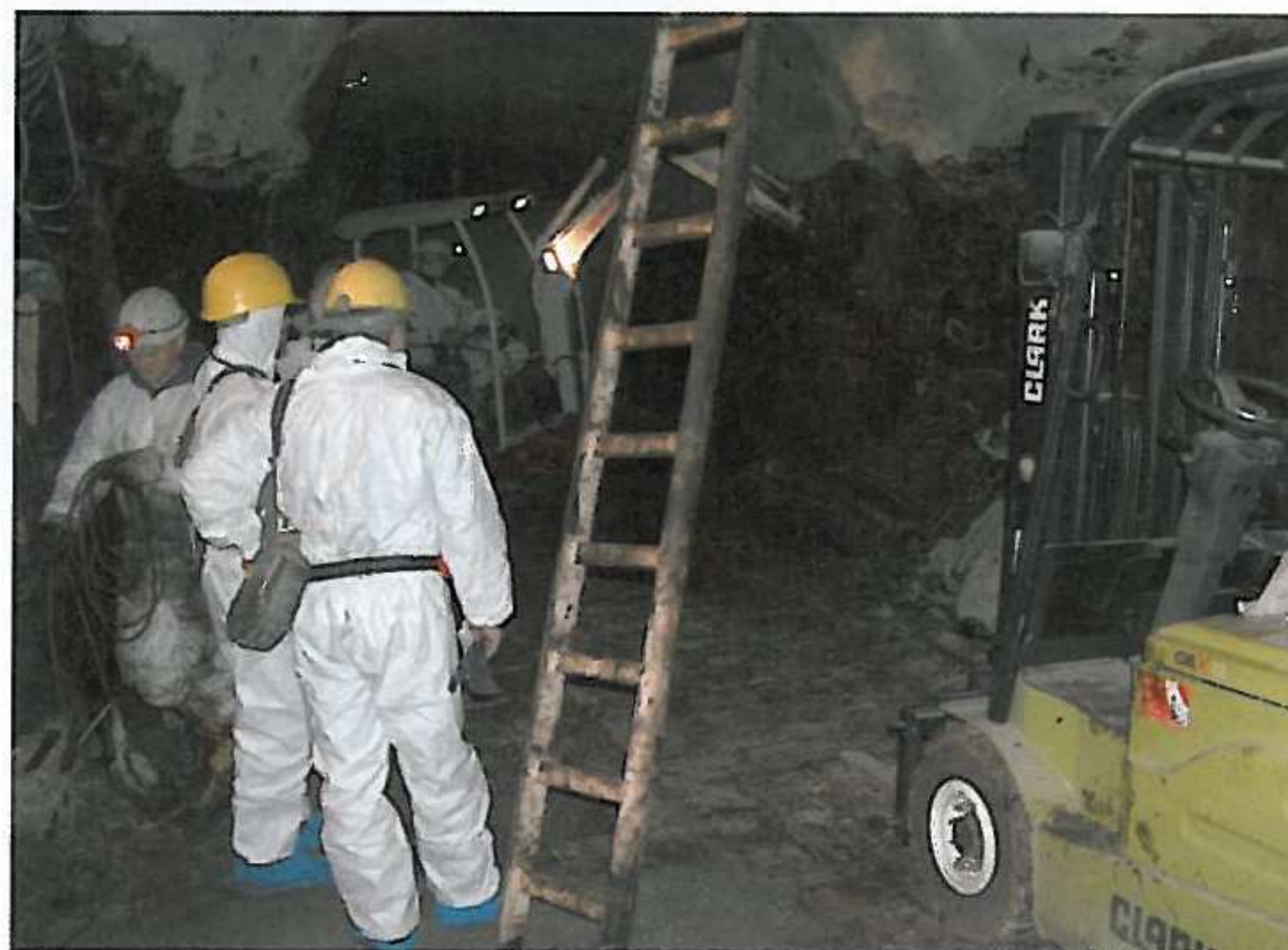
Ungewöhnlicher Arbeitsplatz: Untertage-Arbeiten gehören für Mitarbeiter des Jena-Geos-Ingenieurbüros dazu.
